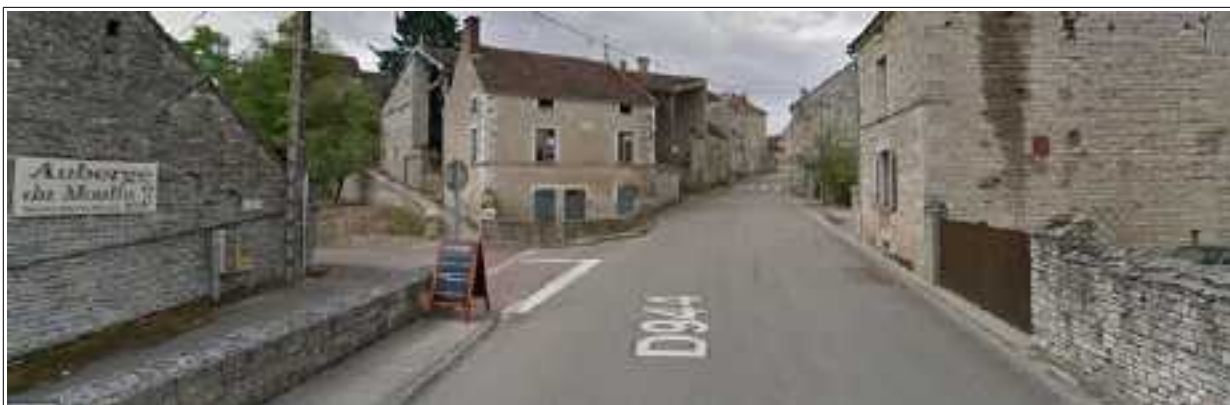
Début de section depuis le point bas (franchissement du Serein) ▲
