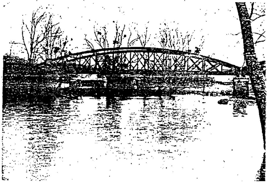
Pont du chemin de fer de Poinchy.
