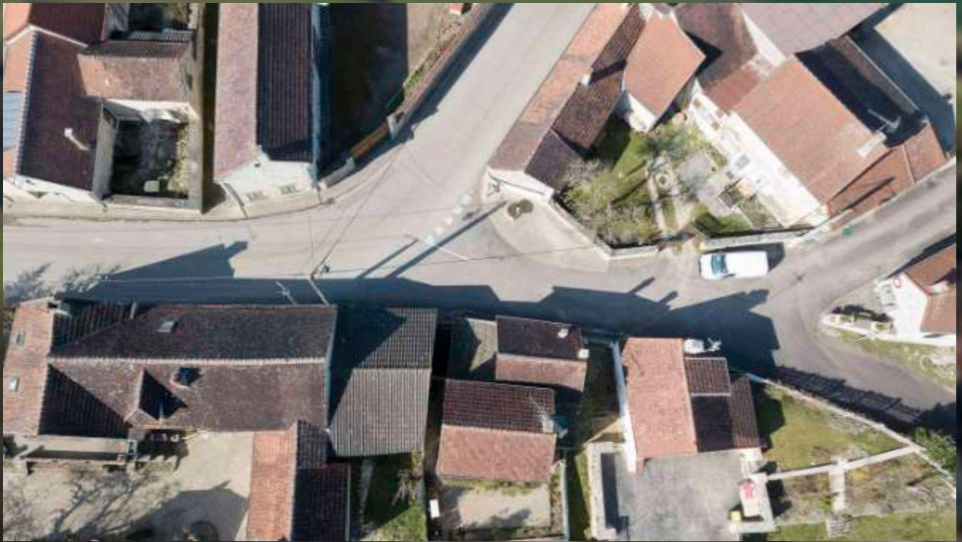
Carrefour Grande rue / rue Sainte Pierre
